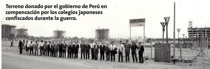
Construcción del Centro Cultural Peruano Japonés.
